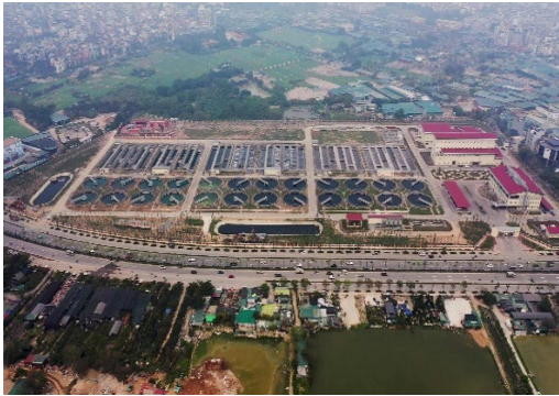
エンサ下水処理場全景（2025年3月下旬撮影）
