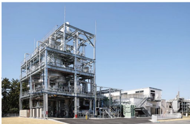
固形燃料化施設
